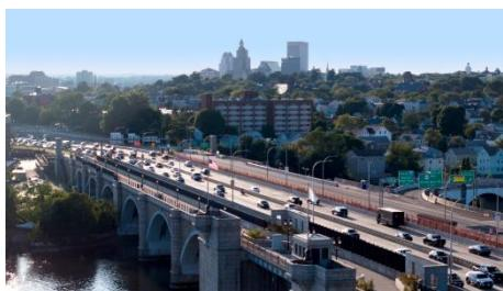
Das Brückenüberwachungssystem der Washington Bridge in Providence, Rhode Island, ist mit Beschleunigungssensoren, Dehnungsmessstreifen, Temperatursensoren, Neigungsmessern sowie einer Wetterstation ausgestattet. Damit werden Daten zum Zustand der Brücke gemessen, gesammelt und ausgewertet. Zusätzlich verfügt die Brücke über ein WIM-System zur Überwachung spezifischer Belastungsbedingungen.
