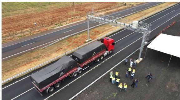
Pedaggio elettronico: le soluzioni Weigh In Motion (WIM) per EcoRodovias sono state installate in collaborazione con l'integratore di sistemi Sinelec.
