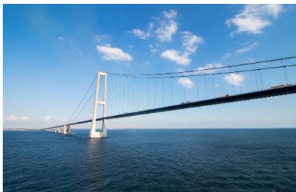
Structural Health Monitoring mit Kistler: Die Storebaelt-Brücke in Dänemark wird mit Hilfe von K-Beam Beschleunigungssensoren laufend auf strukturelle Veränderungen überwacht.
