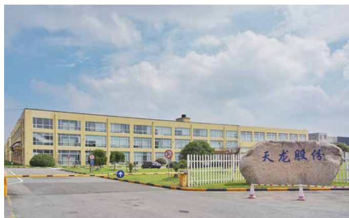
宁波天龙电子股份有限公司的总部位于东海之滨-宁波杭州湾新区。
