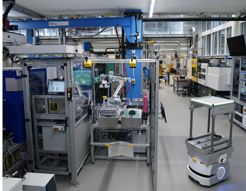
Die fahrerlosen Transportfahrzeuge befördern die Spritzgussteile zur Prüfzelle und anschließend in das Lager für Rückstellmuster.
