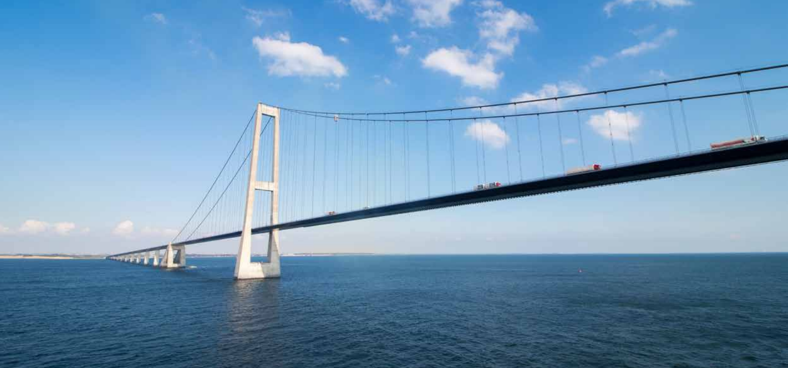
Die Brücke über den Großen Belt in Dänemark, eine der längsten Hängebrücken der Welt, profitiert dank Messtechnik von Kistler von einer Überwachung und Optimierung des Bauzustands.
