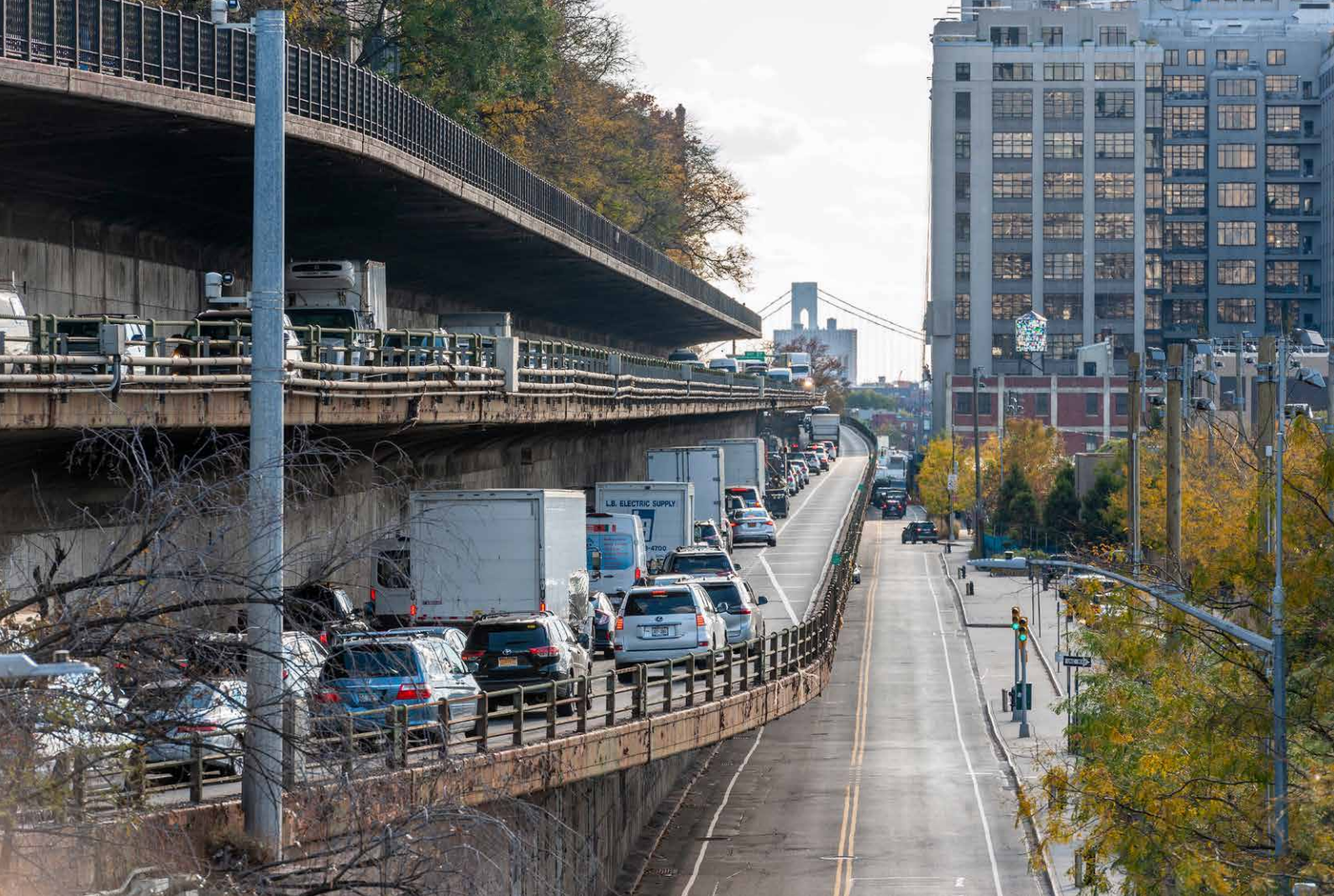
Der Brooklyn-Queens Expressway (BQE) wurde vor mehr als 70 Jahren als dreifacher Ausleger gebaut und ist 2,4 km lang.
