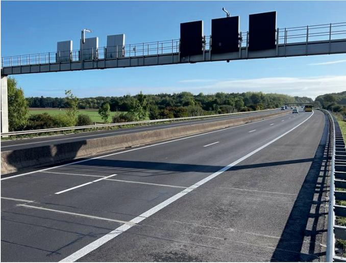
Auf der A6 in Luxemburg installierte Lineas Sensoren für Weigh In Motion Anwendungen und mehr mit KiTraffic Plus Komplettsystem von Kistler – die bestehende Schilderbrücke konnte für die Kamerasysteme genutzt werden.
