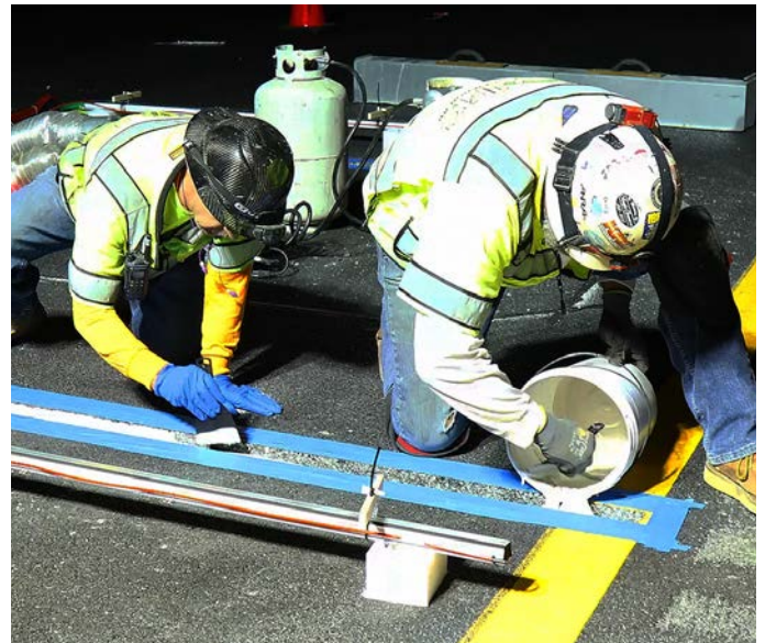
Die enge Kooperation zahlte sich aus: Dank der Bemühungen von PacEx konnte das Projekt innerhalb des Zeitplans beendet werden – trotz verzögerten Materiallieferungen.
