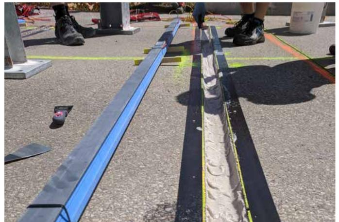
Die Lineas Sensoren für das WIM-System KiTraffic Statistics von Kistler werden etwas unterhalb des Straßenbelags eingebaut und mit einer speziellen Vergussmasse bedeckt, die eine lange Lebensdauer sichert.
