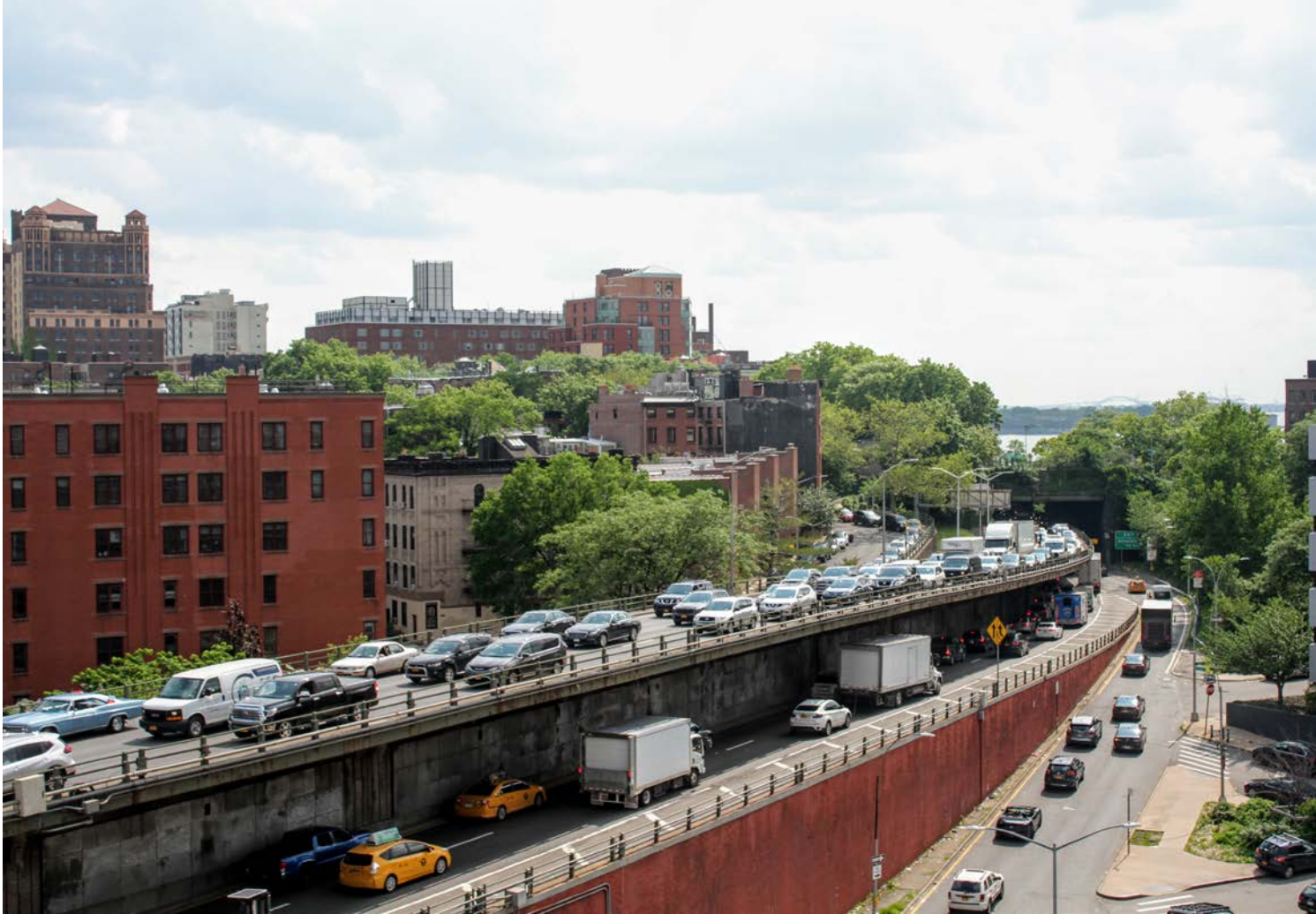
Der Brooklyn-Queens-Expressway (BQE) wurde vor mehr als 70 Jahren als Dreifachausleger gebaut und ist 2,4 Kilometer lang.
