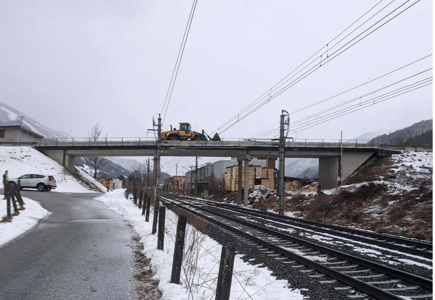
Blick auf die Eisenbahnbrücke in Österreich, die durch schwere Holztransporte beschädigt wurde – und die dank des Weigh In Motion Systems KiTraffic Statistics von Kistler geschützt werden konnte.
