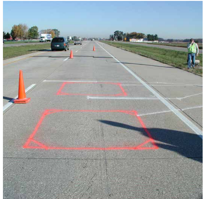
ODOT betreibt momentan 22 Stationen für Weigh In Motion – und plant, in den kommenden Jahren weitere zu installieren.
