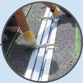
5. Sensor einsetzen
